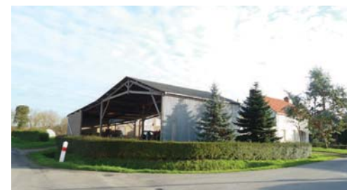
Photo 14 : Hangar agricole encore exploité - Groupe Atelier le 26.02.14
