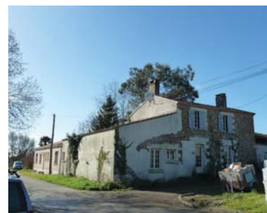
Photo 12 : Bâtisse ancienne : marquage historique - Groupe Atelier le 26.02.14
