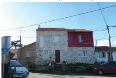
Photo 2: Maison ancienne rénovée avec un bardage bois - Groupe Atelier le 26.02.14
