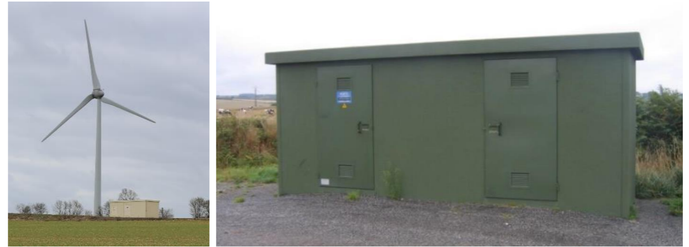
Photo 5 : exemples de poste de livraison électrique
