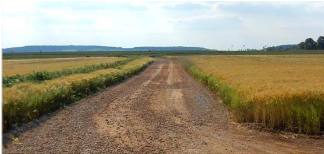
Photo 4 : un exemple de voie d'accès à un parc éolien en milieu agricole
