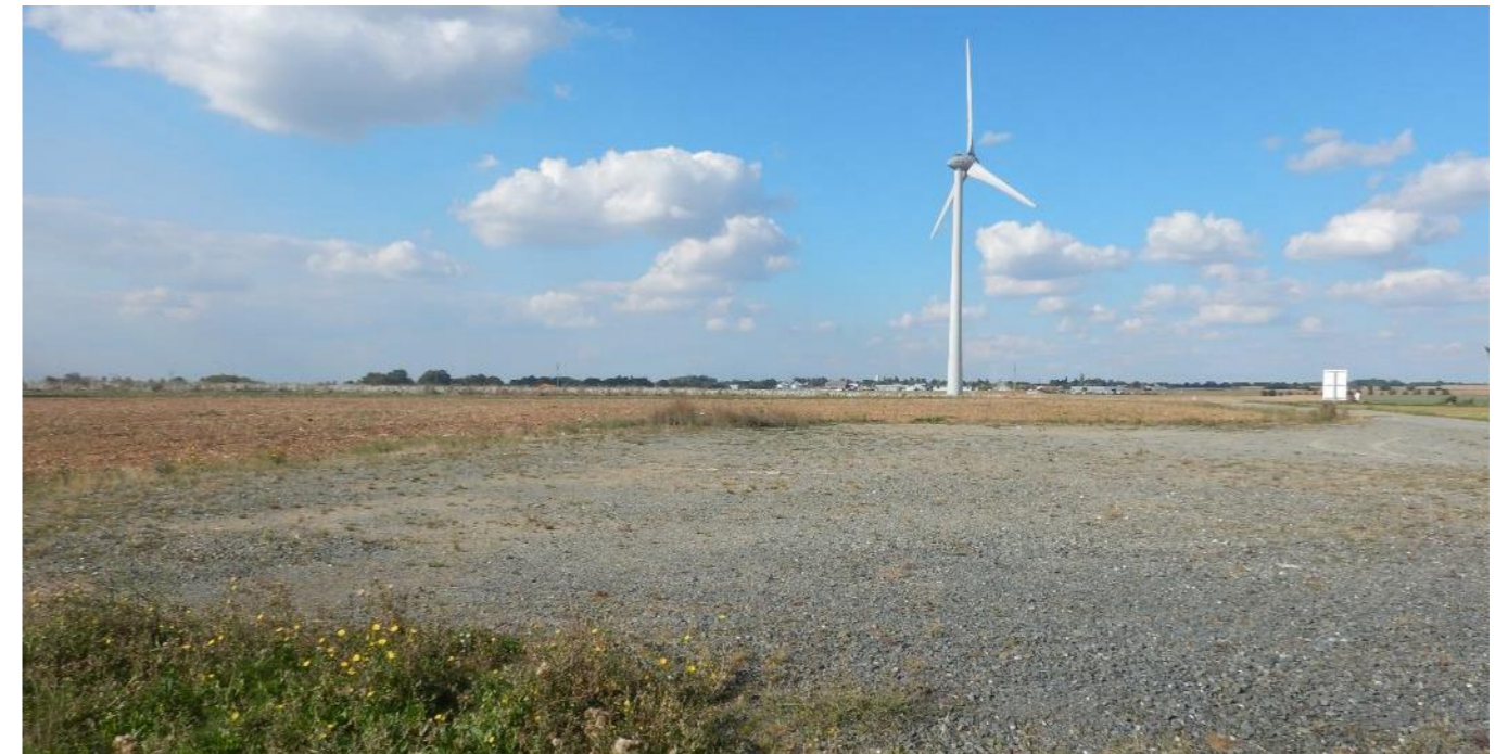
Photo 3 : un exemple d'aire de grutage depuis le pied d'une éolienne
