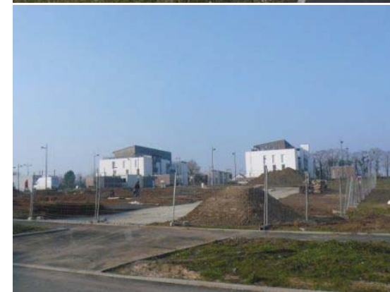
Chantier Loti Ouest - janvier 2010
