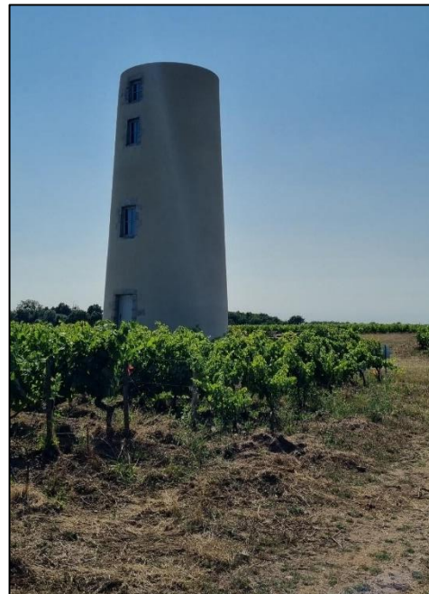
Moulin sur lequel le nichoir sera installé
