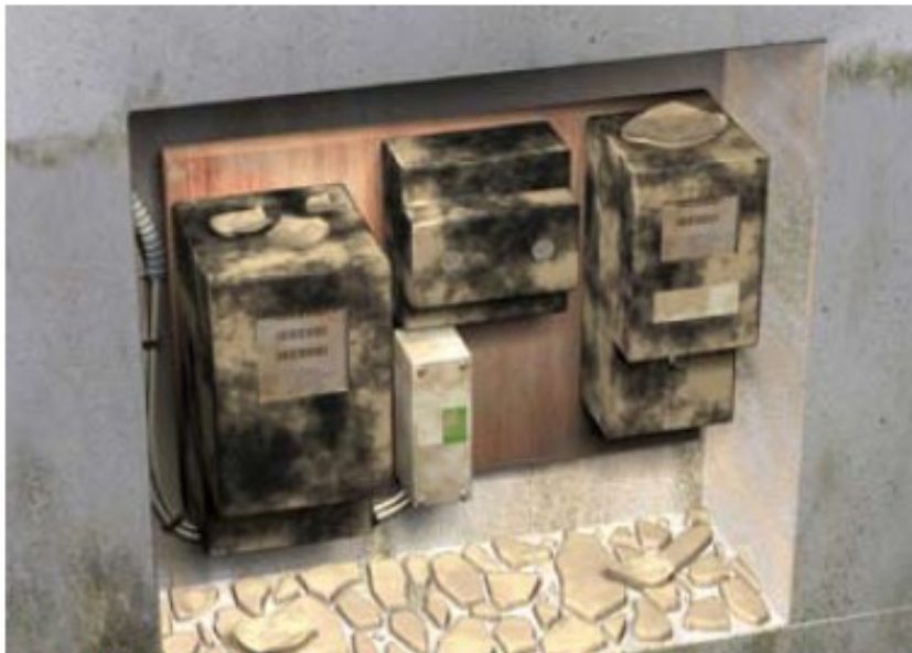
Dégradation d'un coffret de branchement extérieur. Crédit photo
