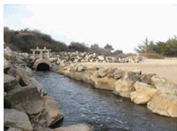
La submersion du secteur pourrait faire suite à la rupture de la vanne qui sépare le marais de l'océan ou à l'occasion d'un phénomène de surcote marine lors d'une tempête. Par ailleurs, la fermeture de la vanne lors de la marée haute bloque l'écoulement des eaux superficielles de l'Etier. En cas de tempête conjuguée avec de fortes précipitations, l'accumulation des eaux de pluie peut ainsi conduire à l'inondation du marais.
