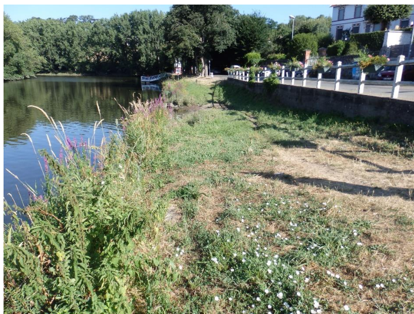
Figure 29. Perrés en amont de la chaussée des moines (à gauche) et perrés en aval colonisés par la végétation © Biotope, 2017
