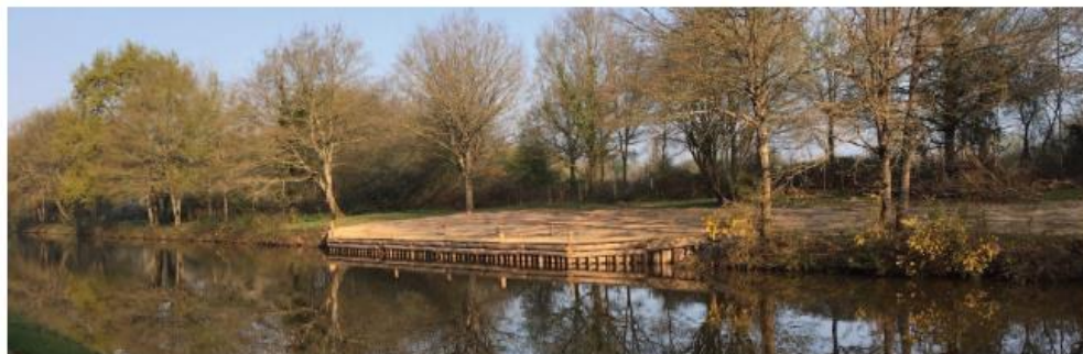
Référence d'aménagement d'un quai de débarquement - Canal de Nantes à Brest
