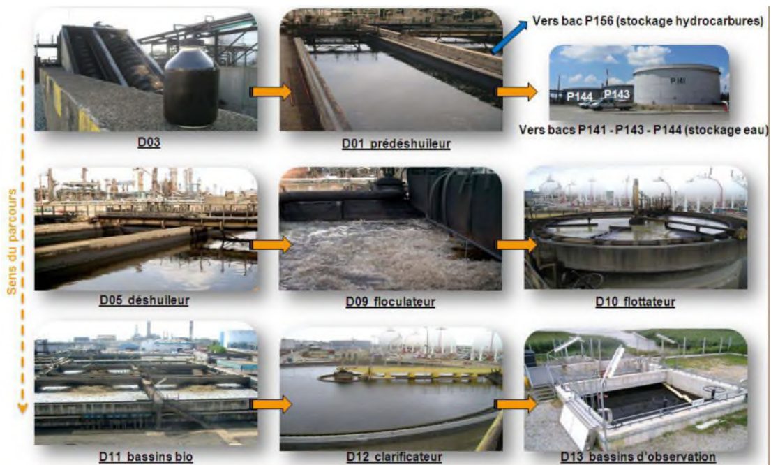
Figure 22 : Cheminement des eaux à travers le TER
