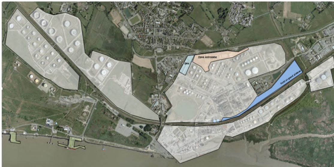
Figure 2 : périmètre de la Raffinerie de Donges
