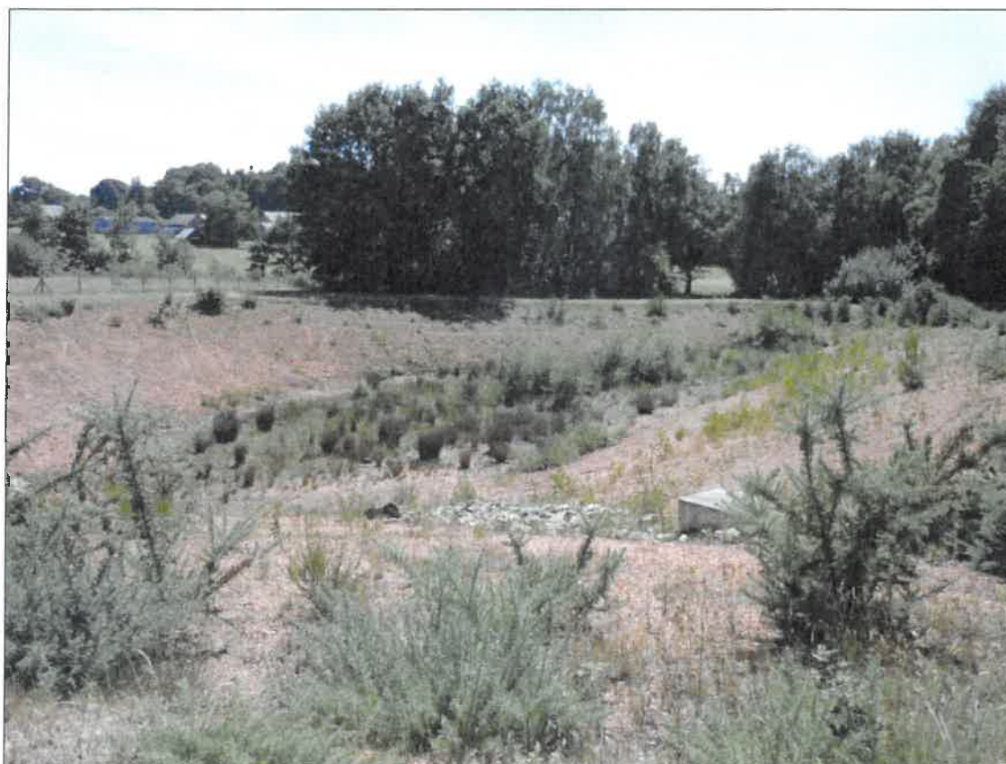
Ouvrage de régulation du SBV 1 – Vue depuis le Nord-Est du bassin
