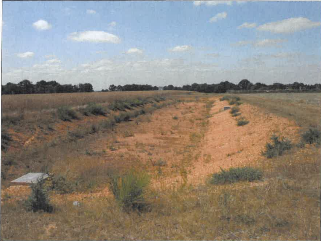
Ouvrages de régulation du SBV 4 – Bassin de 550 m 3 – Vue depuis le Sud des bassins
