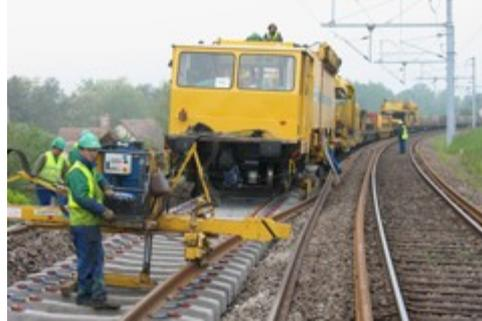
*Longs Rails soudés sur traverses béton*
