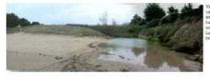
Vue de la section de la voie avec la digue en arrière plan. Au premier plan, visible avec le niveau de l'eau, la zone goudonnée rocheuse.
