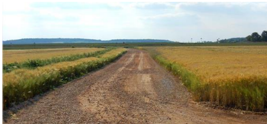
Un exemple de voie d'accès à un parc éolien
