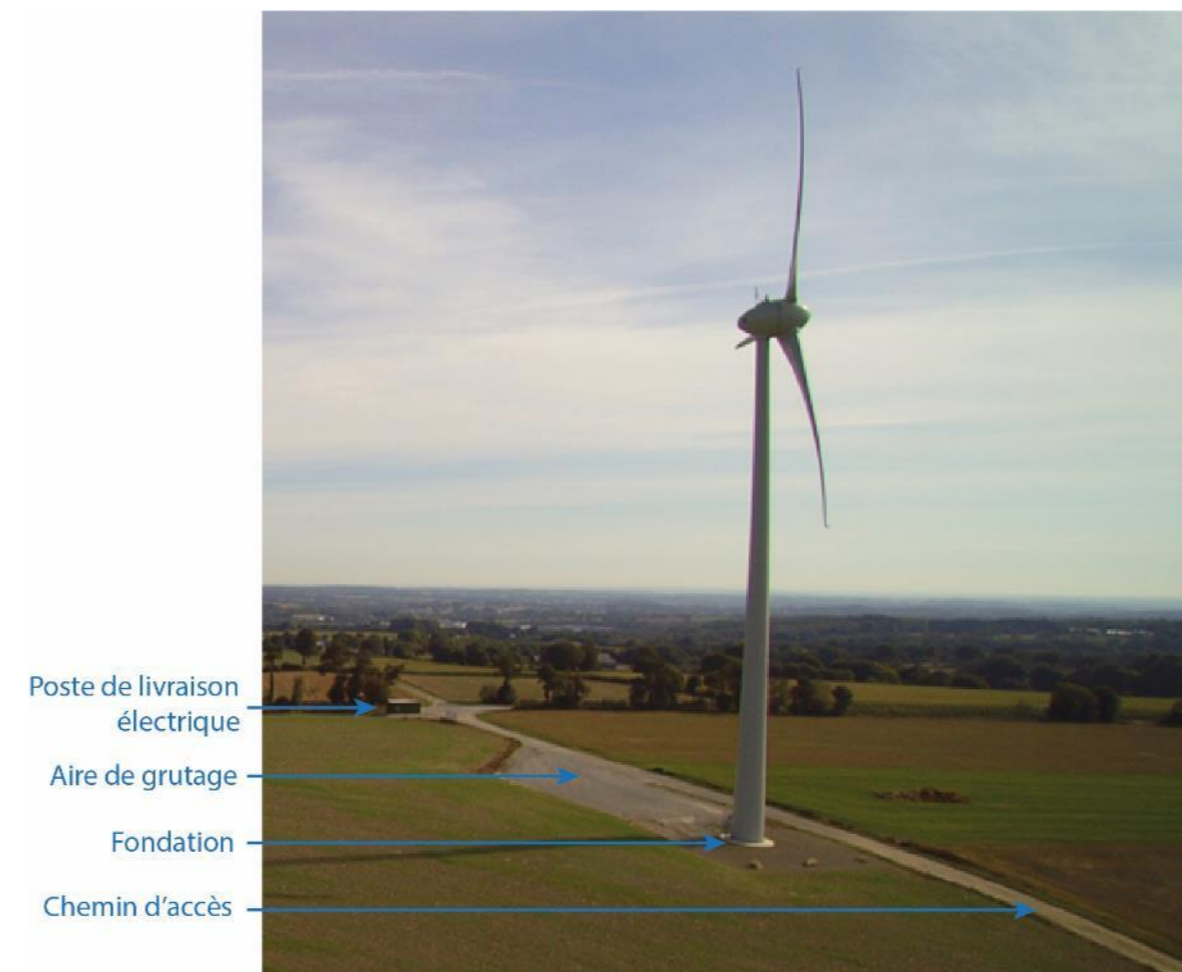
Une éolienne et ses aménagements annexes (AEPE Gingko)
