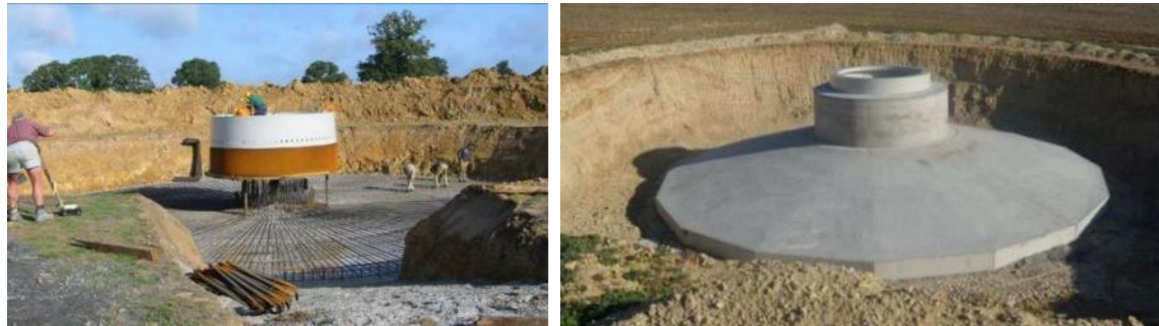
Figure 22 : le ferrailage et le coulage d'une fondation d'éolienne
