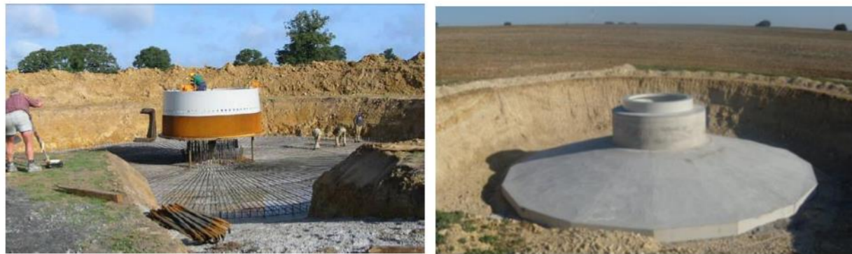
Ferrailage et coulage d'une fondation
