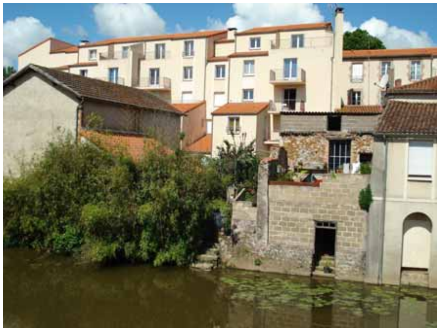
Traversée du bourg de Montfaucon : 44 habitations en zone inondable
