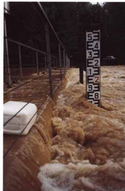
Le Moulin de Bouchot – crue de mai 2000
