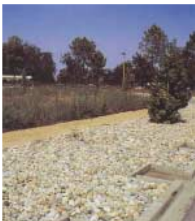
Tranchée sous-trottoir Av de la Grande Lande - GRADIGNAN - 33 Source CETE du Sud-Ouest.
