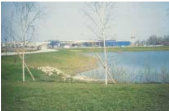
Bassin en eau du parc technologique de Saint-Priest Porte des Alpes Source CERTU
