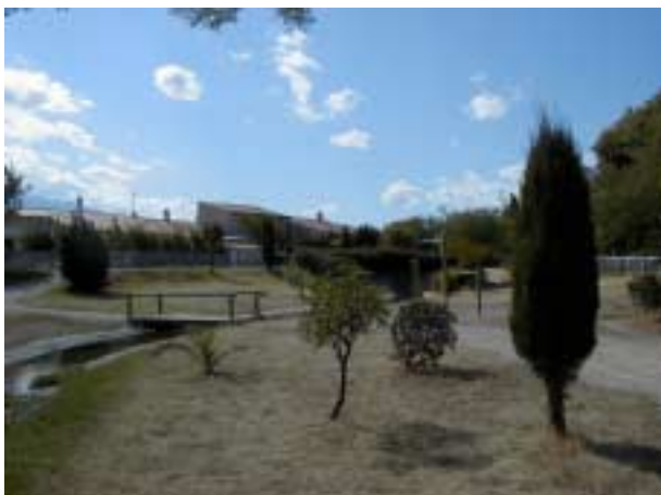
Bassin sec à Ille sur Tet (66) Source DDE 66
