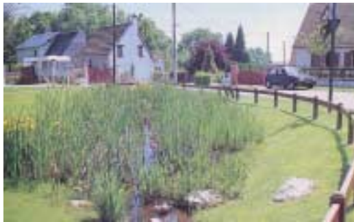
Noue engazonnée Opération Belbeuf – 76 Source Foncier Conseil
