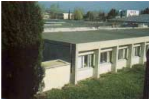
Toiture – terrasse Source CERTU
