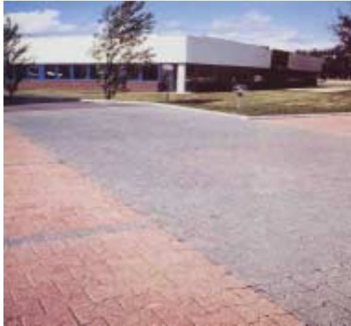
Parking réservoir et pavés drainants de la zone d'activité du Phare (33) Source CETE du Sud-Ouest
