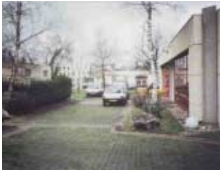
Tranchée autour d'un bâtiment Source CETE du Sud-Ouest
