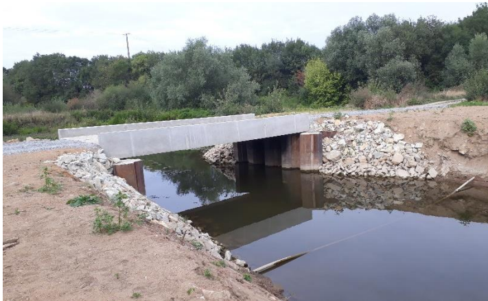
2. Restauration du gué de l'Aireau dans la boire d'Anjou (2019)
