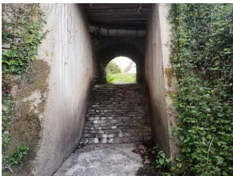
Figure 28. Évacuateur de crues
