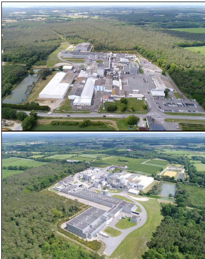
Fig. 3 : Vues de l'environnement du site (vers l'ouest et vers l'est)
