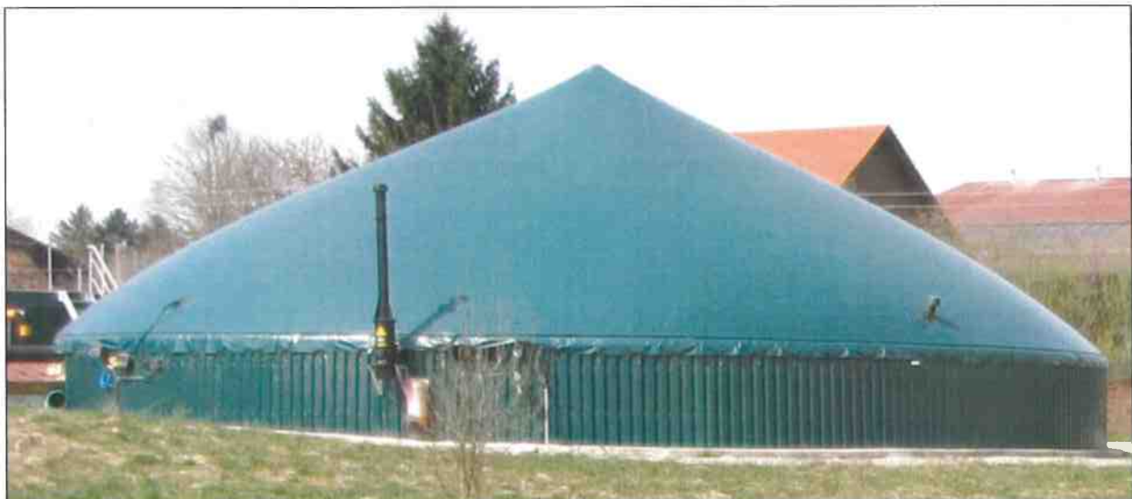
Exemple d'image : Toit à double membrane pour le stockage de biogaz
