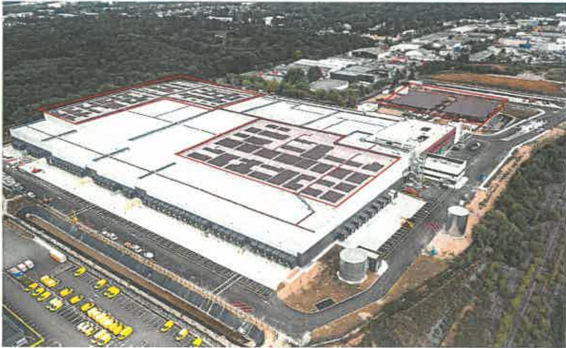
Figure 3: Emplacements des panneaux photovoltaïques
