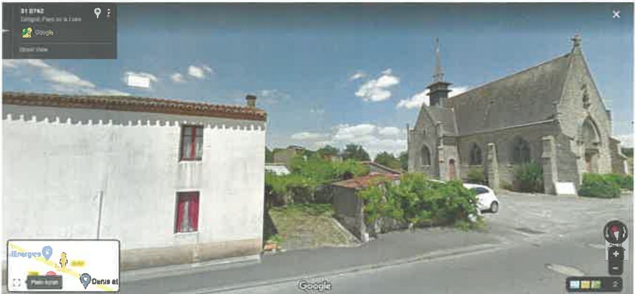
Photo 1 : Vue partielle sur le bâtiment concerné.
