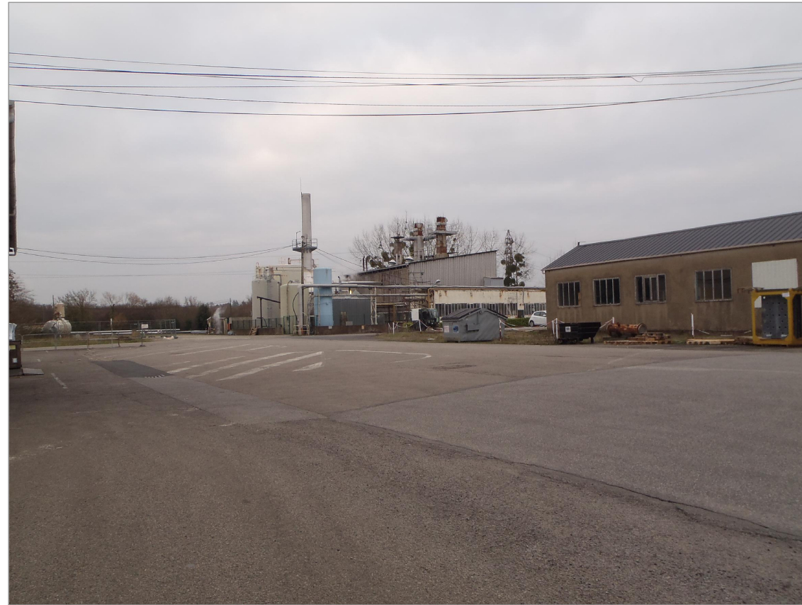
Photographie du terrain loin - PC8 - 31 01 2022
