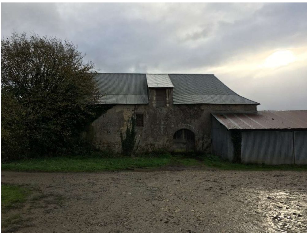
Figure 14 . Grange où seront installés 10 nichoirs à Hirondelle rustique
