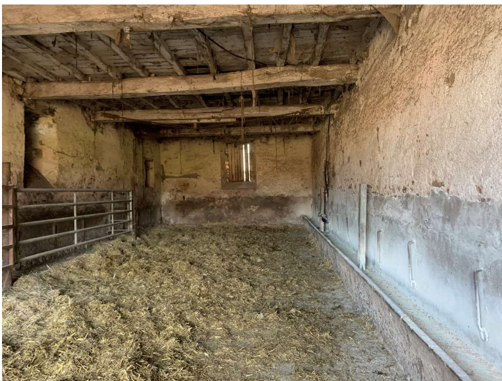
Figure 15 . Intérieur de la grange qui sera maintenue ouverte et où seront installés 10 nichoirs à Hirondelle rustique (intérieur du bâtiment)
