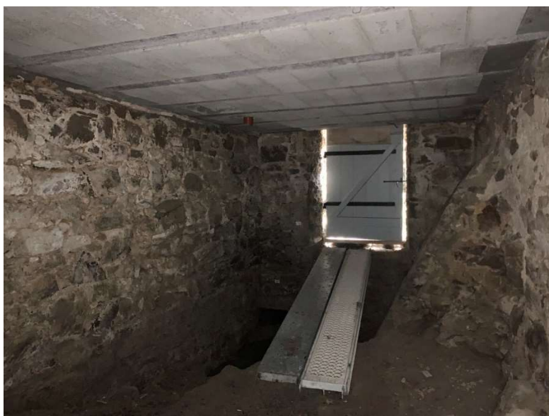
Figure 21 . Porte où sera créée une ouverture en haut à gauche
