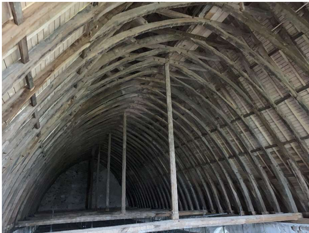
Figure 10. Photo de la charpente de l'abbatiale
