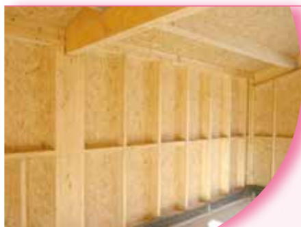
Murs à ossature bois
