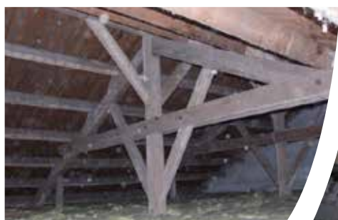
Charpente en combles perdus
