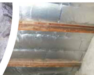
Chevrons masqués par un isolant
