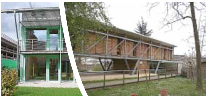
Construction sur poteaux béton
