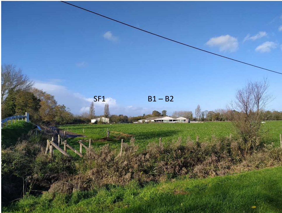
Vue 1 : Vue éloignée depuis la route communale qui dessert le site de la Louisiane. Le site est bien inséré dans un paysage rural, à vocation agricole. Le choix des matériaux et de la couleur des bâtiments est harmonieux dans le paysage.
