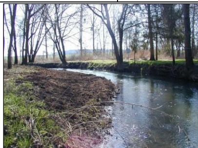
Mise en place de remblai derrière les fascines
