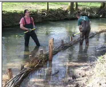
Réalisation de fascine en pied de la nouvelle berge
