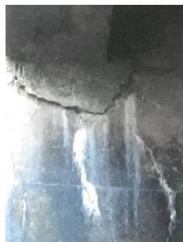
Fissure présente sous le tablier du pont
