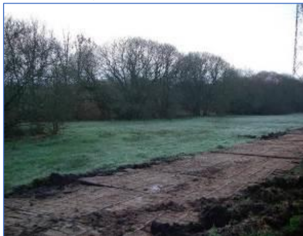
Figure 27 : Exemple d'un cheminement provisoire en bois qui protège le sol de la parcelle (bassin du Rion, chantier ERDF)
