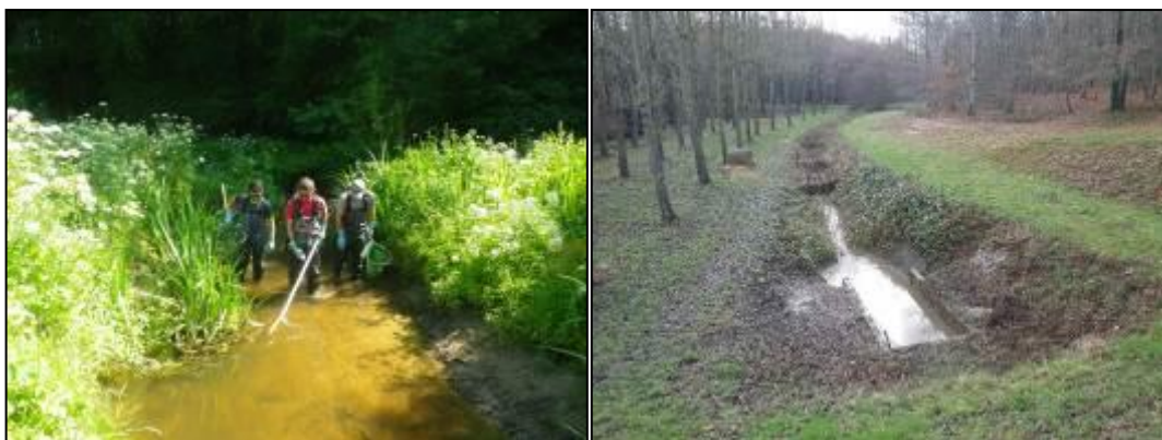
Figure 31 : Action de pêche électrique sur le Loc'h et mise en place de filtre à paille en amont d'une zone de travaux sur le Long
