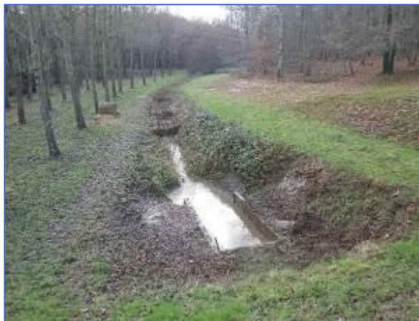
Figure 26 : Exemple de mise en place de bottes de paille dans le lit de la rivière le Long (37), à l'aval d'un étang lors de sa vidange
