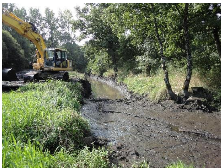
Figure 6 : Restauration de la capacité hydraulique du canal par curage
