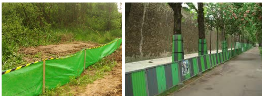
Figure 30. Illustration de mise en défens en phase chantier
