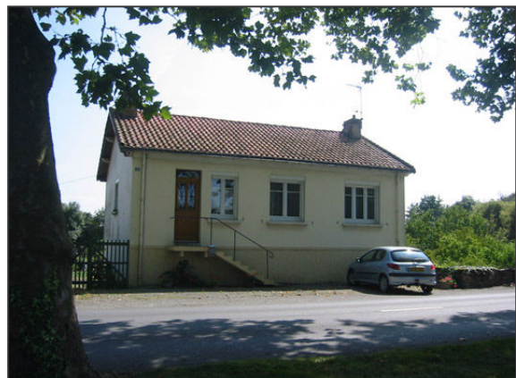
Constructions adaptées à l'inondabilité dans le quartier du Pont à Paulx.
