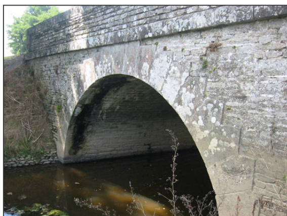
Le pont sur la RD 63
