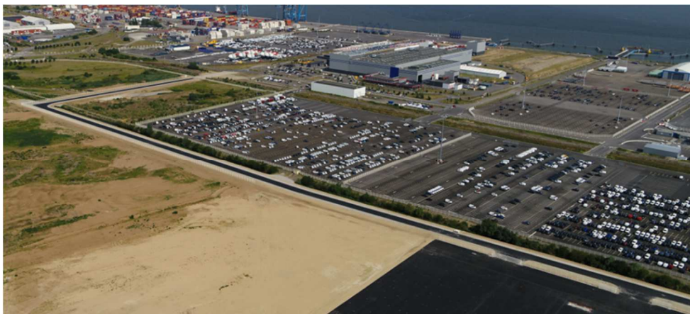
Voirie XXL, en juillet 2021 – source GPMNSN
