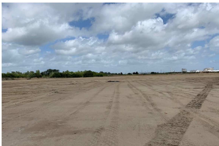
Photo du site du 27/05/2021 – source GPMNSN
