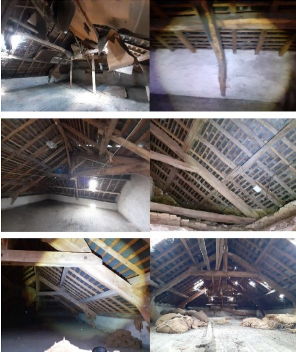
Visite des combles des différents bâtiments de l'îlot Datin (visite du 17 mai 2022)
