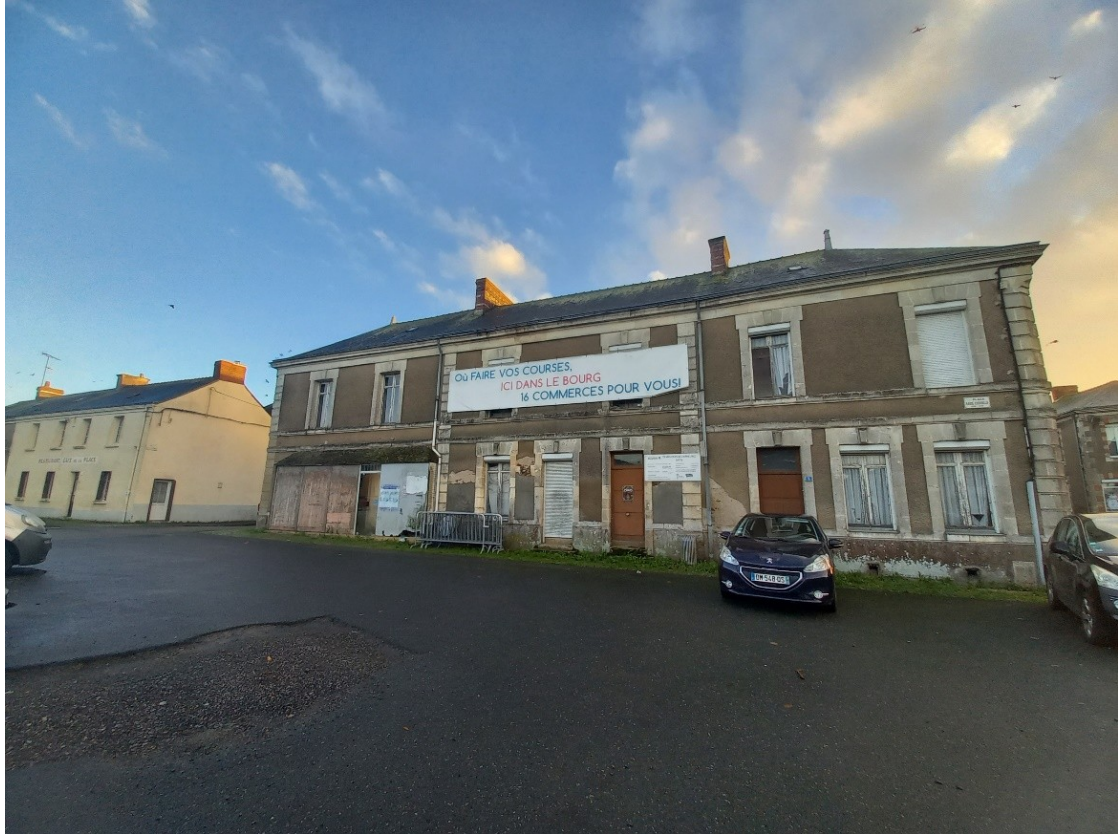
Zone d'étude (îlot Datin dans le centre-bourg de Bouvron – photo : SEGED)
