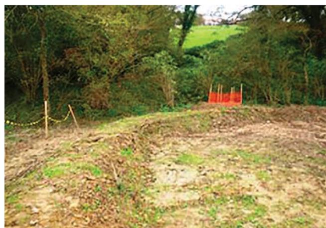
Exemple de merlon en bas de pente, équipé d'une surverse (identifiée en orange). Il protège une berge défrichée et dirige l'eau vers un milieu végétalisé (Guide OFB, 2018)
